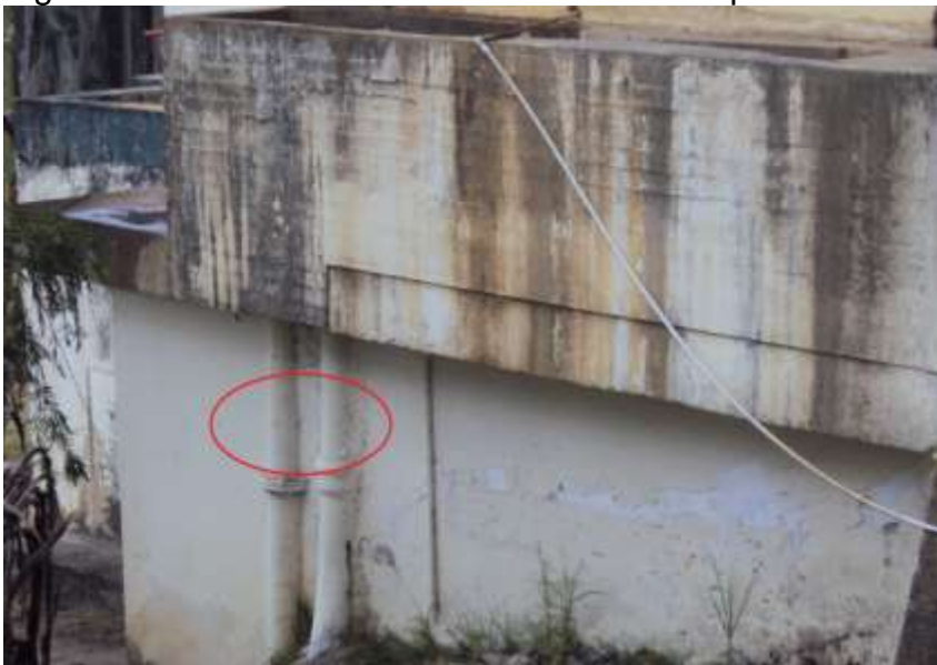
Figura 40. Tubería de alimentación de caudal para el canal Parshall.
